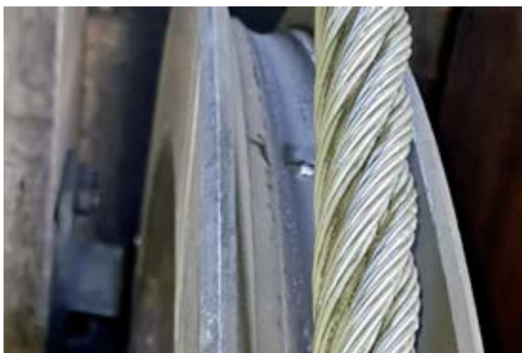
Abbildung 1: Zugseil und Einlageschnur mit Stahlbolzen (Quelle: Seilgruppe Schweiz)
