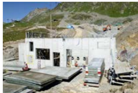
Der Bau der Ablasswasserstation ist schon weit vorgeschritten.
