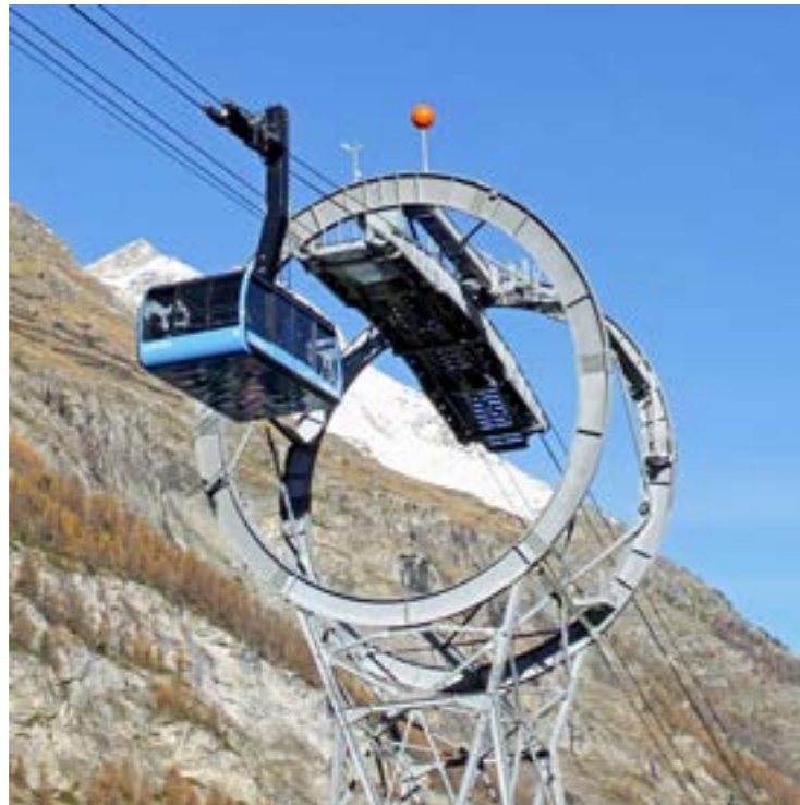
Eine der vielen Besonderheiten der neuen Pendelbahn ist die erste Stütze die in Form einer Lupe konstruiert ist.
