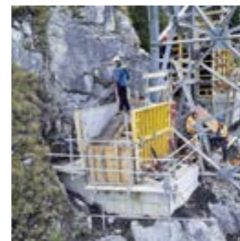
Die Bauarbeiten an den Stützenfundamenten gestalteten sich herausfordernd.
