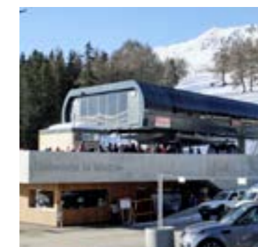
Die Talstation in Les Collons 1900 besteht aus einem Erdgeschoss, auf welchem die Station aufgebaut ist.
