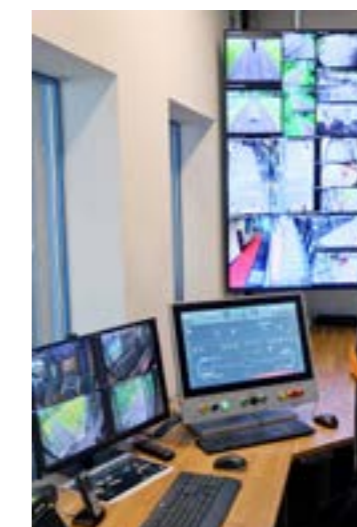
Auf dem Grossbildschirm in der Bergstation können gleichzeitig auf 17 Stellen eingesehen werden.
