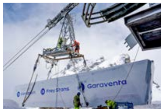
Die neuen Wagen wurden mit einem verstärkten Gehänge mit der Felskinnbahn auf den Berg gefahren.
